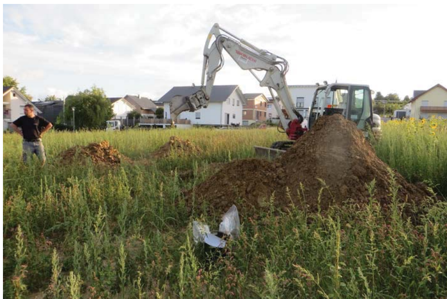
Bild 1 + 2: Schurf 3 - unter einem ca. 0,3 m starken Oberbodenhorizont wurde bis zur Endtiefe von 2,60 m Kies mit relativ hohen Schluffanteilen angetroffen. Hinweise auf Grund- oder Schichtwasser waren nicht zu erkennen.
